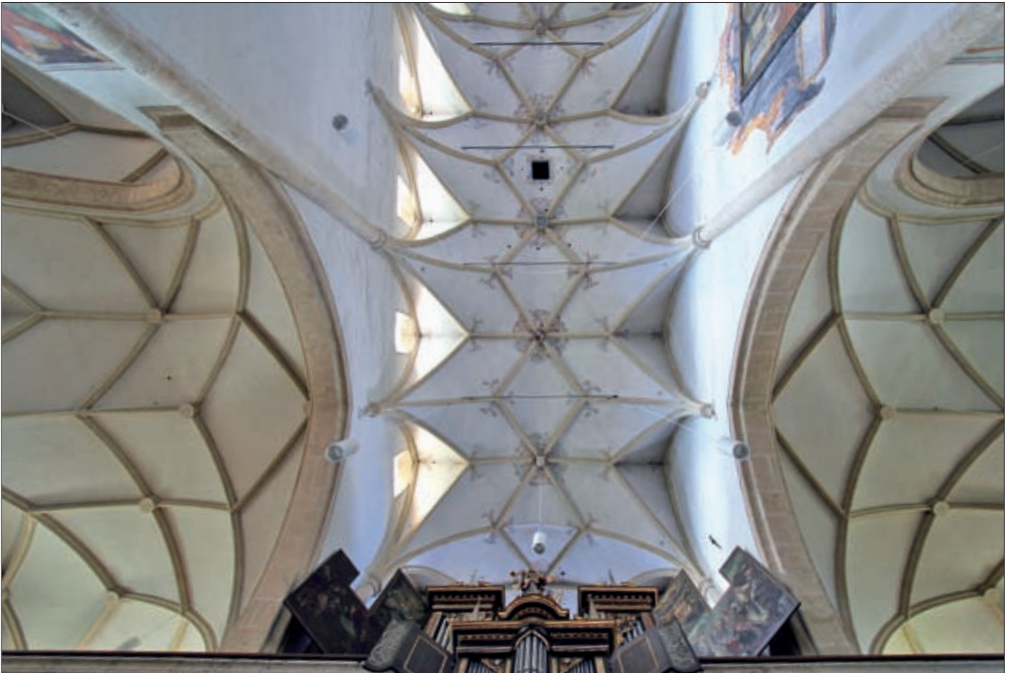
Blick in die spätgotischen Gewölbe des Hauptschiffs und der angrenzenden Seitenschiffe im hinteren Teil von St. Andrä.
