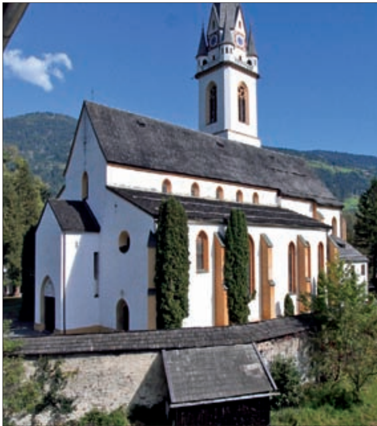
Stadtpfarrkirche zum hl. Apostel Andreas in Lienz. – Das in seiner Geschichte weit zurück reichende Gotteshaus wurde in der Zeit der Spätgotik als dreischiffige Basilika neu errichtet. Deutlich ist das weit über die beiden Seitenschiffe erhabene Mittelschiff mit dem südlichen Lichtgaden zu erkennen.
