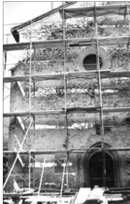
Nach Abschlagen des Putzes der Westfassade im Jahr 1968 war die ehemalige Nord-West-Kante der romanischen Kirche zwischen dem Spitzbogen des linken gotischen Seitenportals und dem darüber liegenden Rundfenster gut zu erkennen; Aufnahme 9. September 1968.
