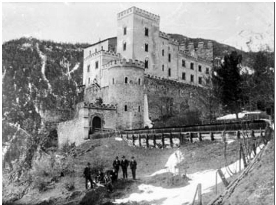
Schlossstor mit Erweiterungsbau um 1895.
