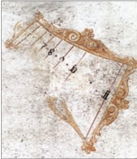
Lienz, Tammerburg, bei der Fassadenrestaurierung 1999 neu aufgetauchte Sonnenuhr, zweite Hälfte 17. Jahrhundert.
