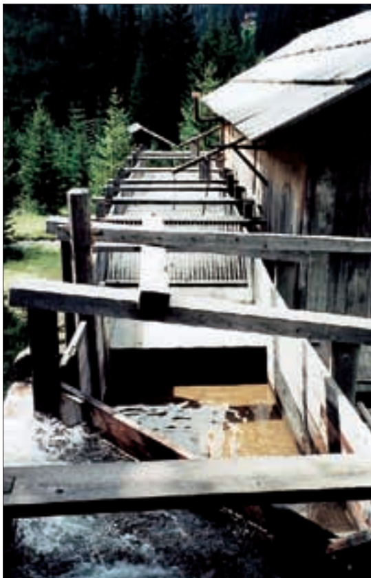
◀ Die „Wiere“ mit „abgekehrtem“ Wasser. – Der eingelegte „Rechen“ soll Steine und Holzstücke von den Wasserrädern fernhalten.
