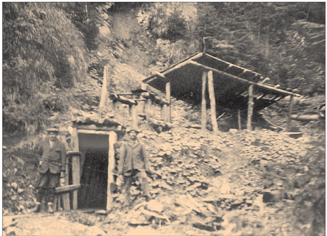
Mundloch (Stolleneingang) „Römerstollen“.
