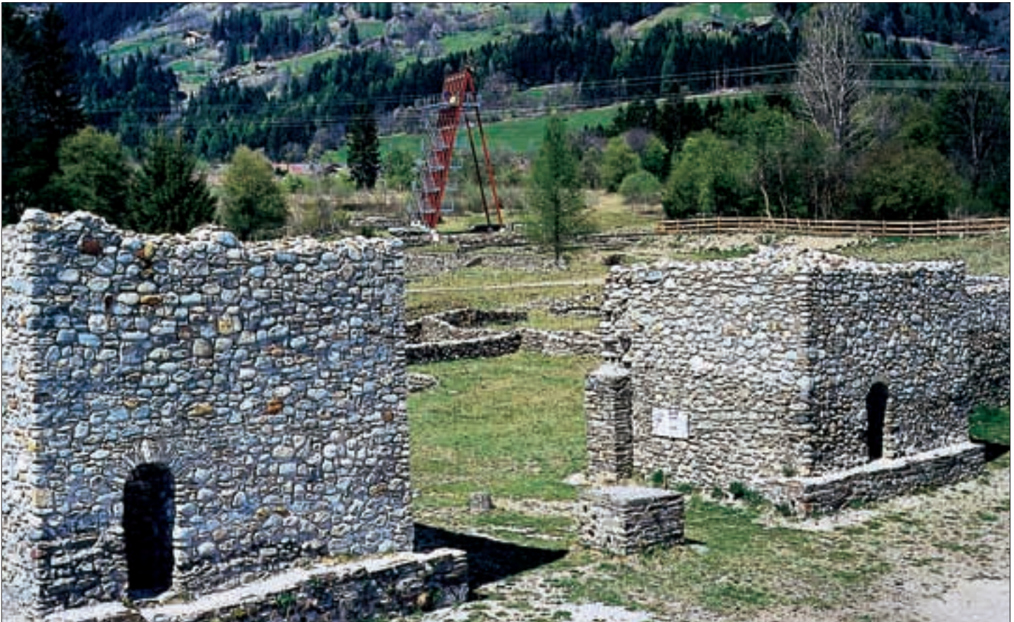
Die wiederaufgebauten Türme, die die große Toranlage von Aguntum flankieren. In der Mitte hinten der neue Aussichtsturm.
