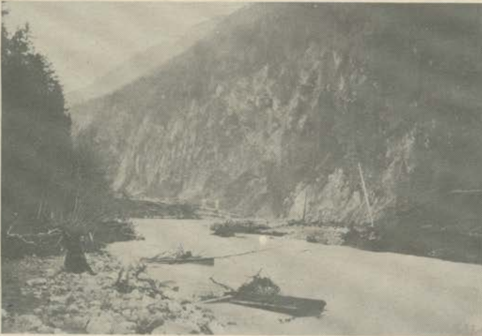
„Parthie vor der Station Mittewald“, Strecke Thal–Mittewald, 1882
