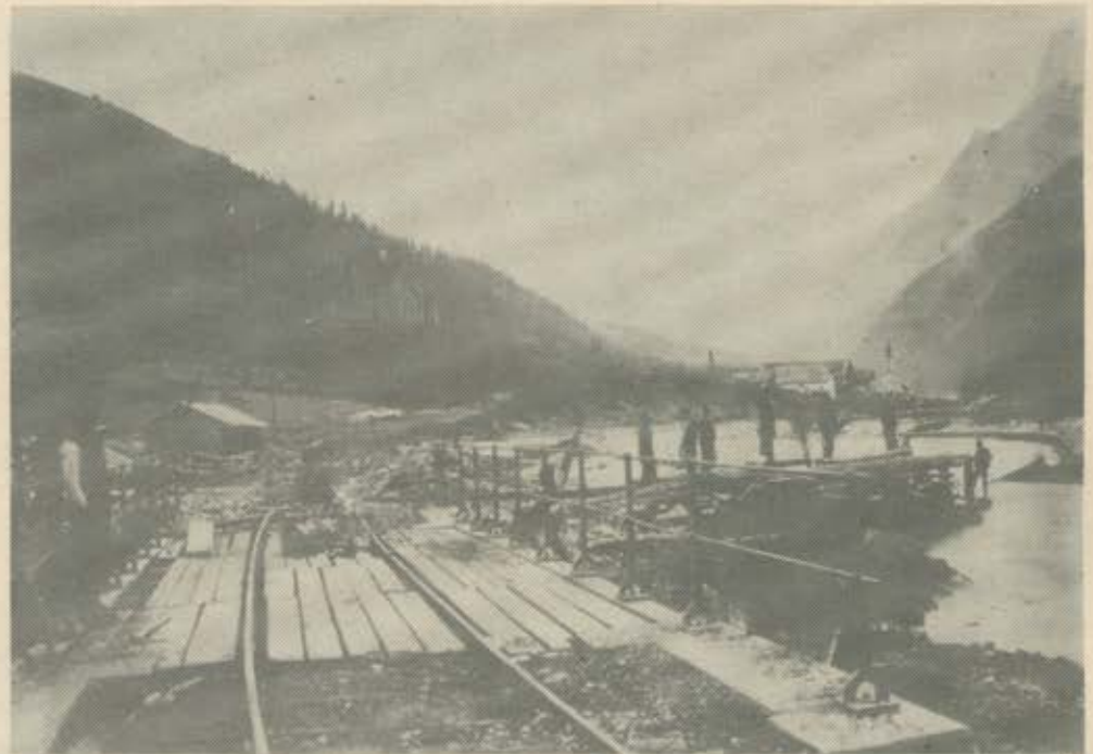
„Parthie bei der Thalerbach-Brücke, Strecke Thal-Mittewald“.
